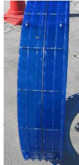
補強鉄線取付完了状況
