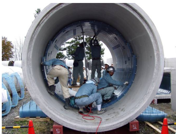
写真-4.5.1 上下流同時組立（呼び径 2600）
