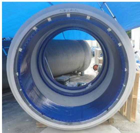
サポートレス施工 スペーサー設置の例：呼び径 1800
