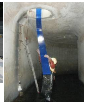
矩形管用部材搬入状況の例
