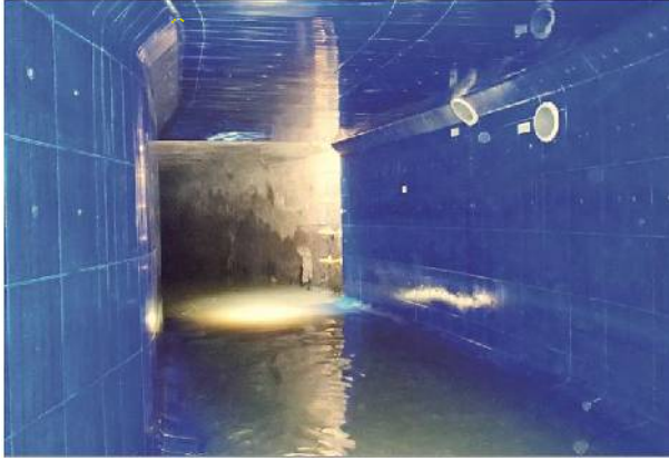
矩形管（曲線施工） □2200×1970 曲率半径 R4.2m
