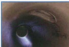
本管更生前に取付管を更生し、本管更生後に取付部を穿孔。
