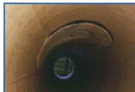
本管更生後に取付管接合部を穿孔し、取付管を施工。
